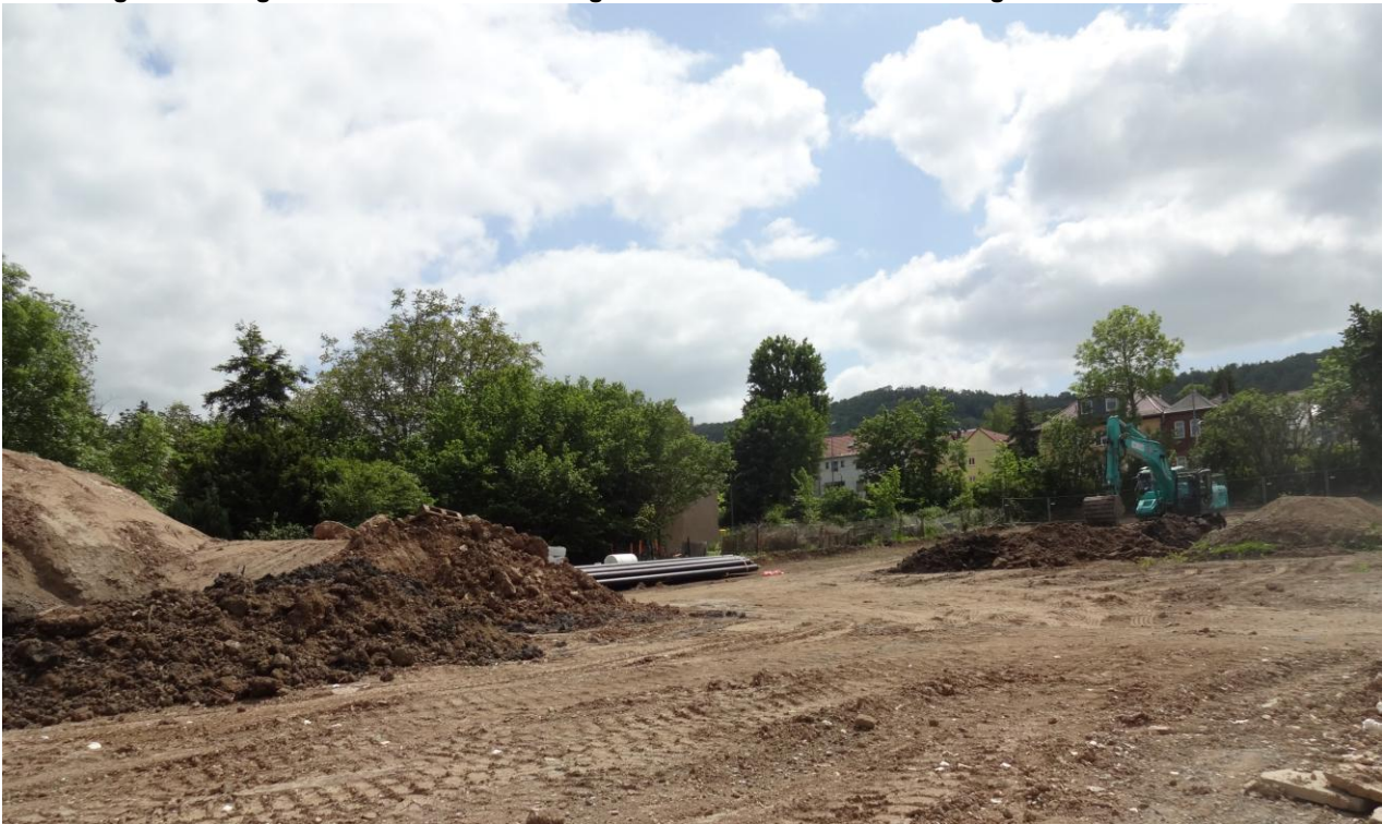
Abbildung 2: Nutzung der Fläche des Vorhabensgebiets als Baustelleneinrichtung
