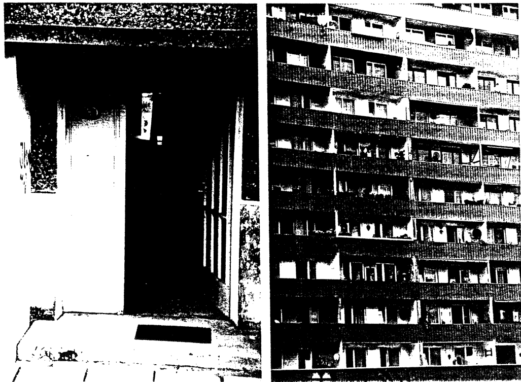
Unbefriedigende Eingangsgestaltung und monotone Fassade
