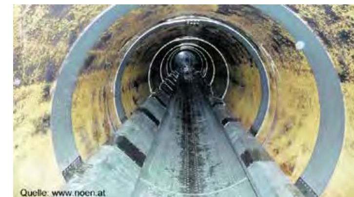
Abb.: Plattensystem zur Wärmegewinnung in einem Kanalrohr in Baden (Schweiz)
