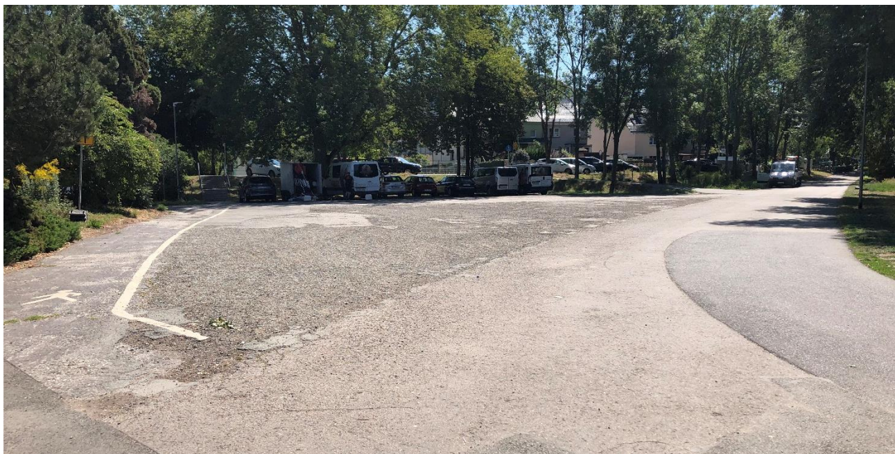
Abbildung 13: Blick auf den südlichen Teil des Gries-Platzes, Stand: 08/2022
