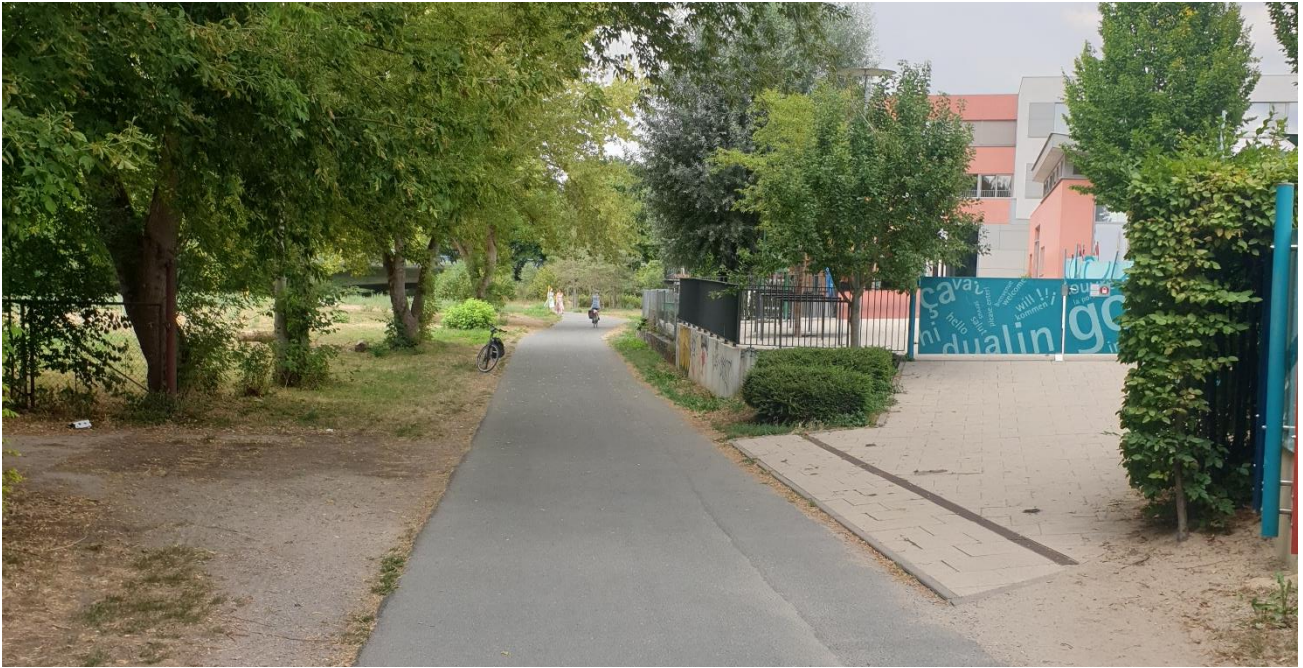
Abbildung 18: Fuß-/Radweg mit Konfliktbereich Eingang Dualingo, Stand: 08/2022
