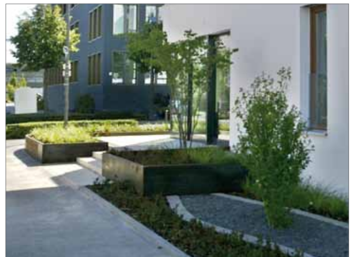
Differenzierter Vorbereich eines Gewerberaumes; Riedberg, Frankfurt
