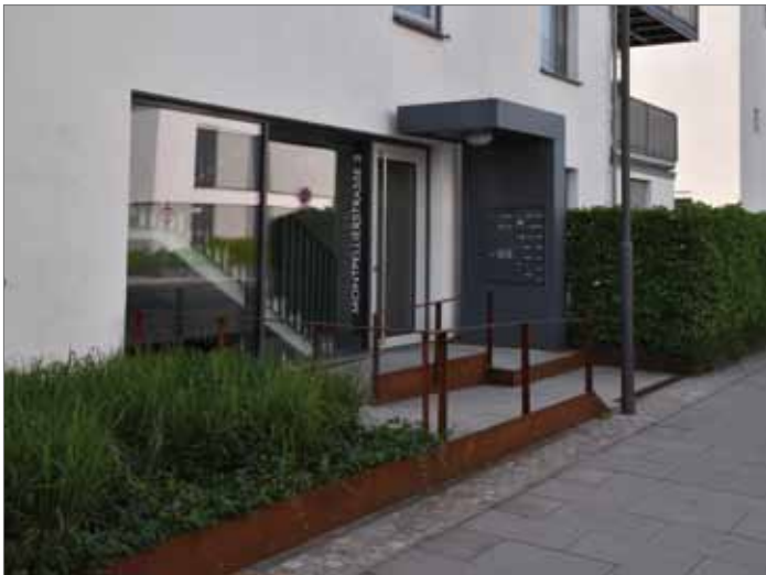
Höhensprung durch Stufen und Rampe bewältigt; Bahnstadt, Heidelberg
