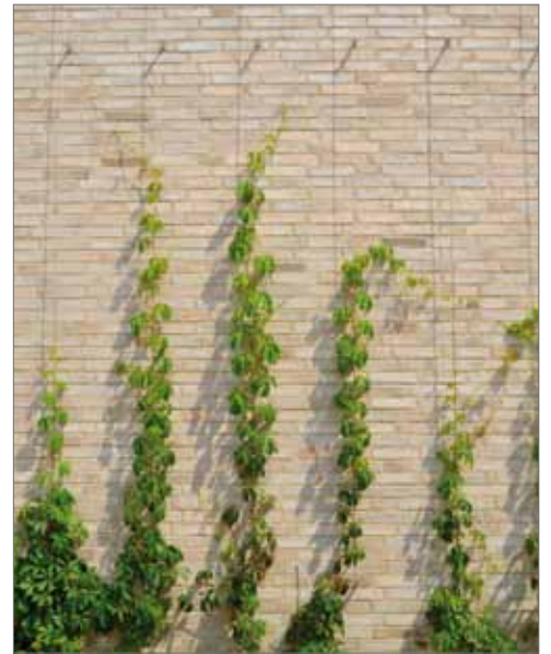
Seilgeführte Fassadenbegrünung mit Wildem Wein; Potsdam
