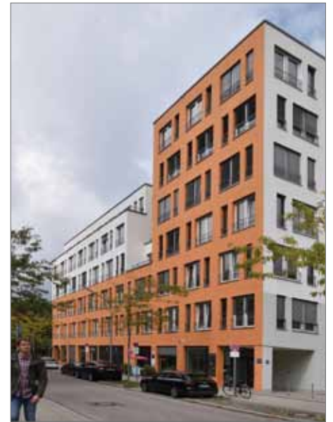
Eckbetonung durch höheres Haus; Ackermannbogen, München
