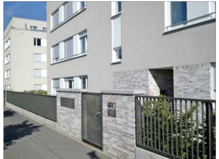
Einfriedung mit Gartentor, Klinker der Fassade aufgenommen; Riedberg, Frankfurt
