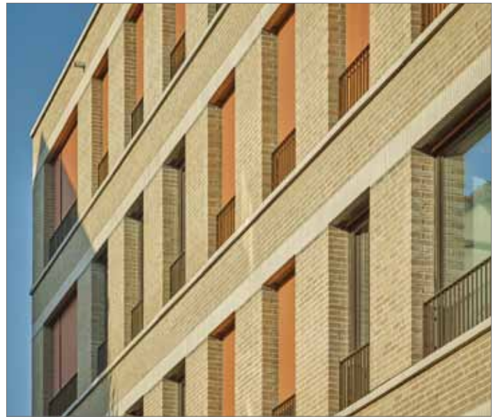
Klinkerfassade mit Gesimsbändern; Tiergartenstraße, Dresden
