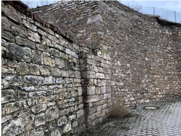
Abbildung 9: Verfugte Mauer, Foto: J. Schulz
