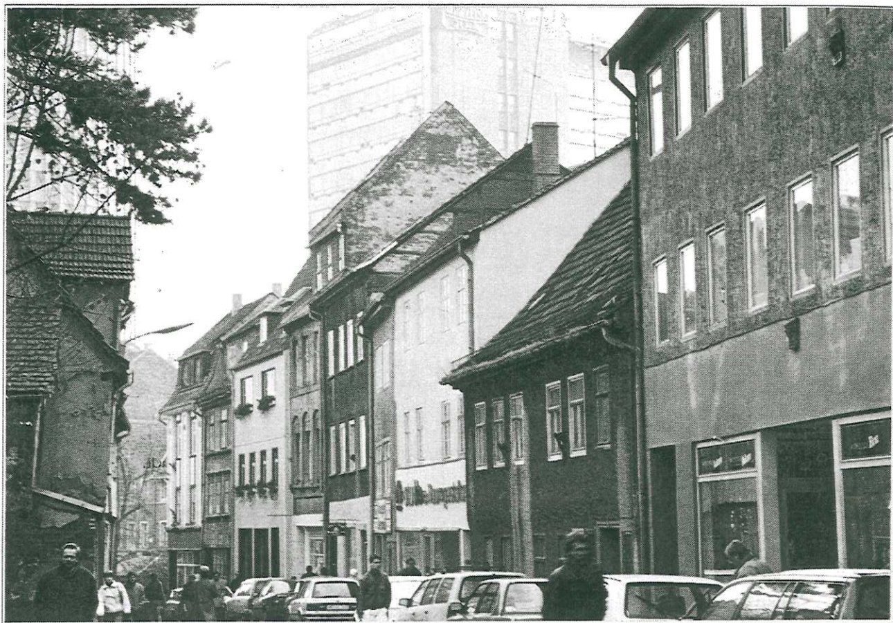
Wohnhäuser in der Wagnergasse
