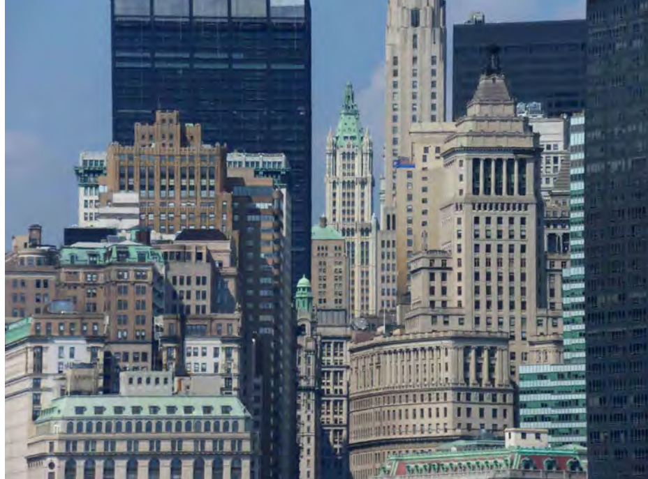
Abb. 6 Hochhausbau als Spiegel der Baustilgeschichte
