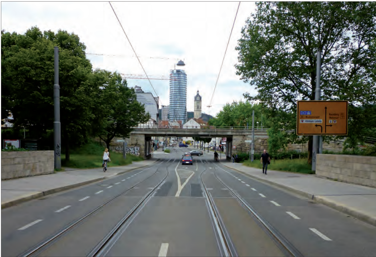
B Straßenansicht Camsdorfer Brücke, Blickrichtung Ost, Bestand
