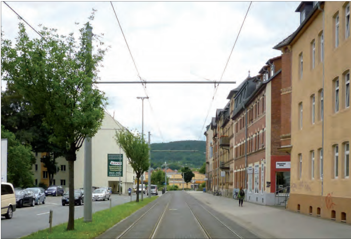
A Straßenansicht Dornburger Straße, Blickrichtung Süd, Bestand
