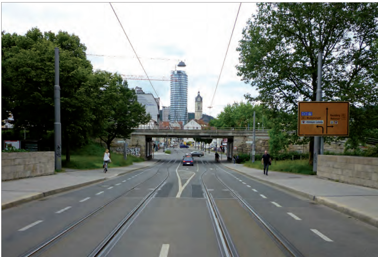
B Straßenansicht Camsdorfer Brücke, Blickrichtung Ost, Bestand
