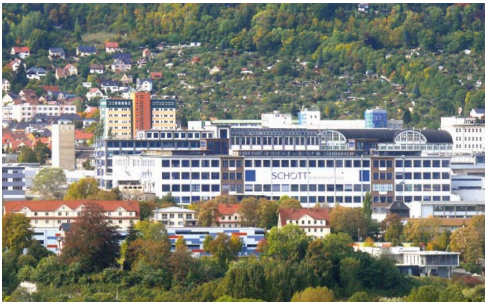
Zu reaktivierende Gebäudesubstanz im Areal Tatzendpromenade
