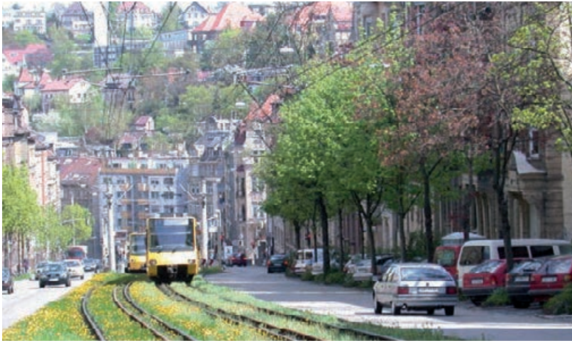
Abbildung 11.6: Rasenbahnkörper der Stadtbahn in Stuttgart (Quelle: AUS 2010)
