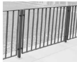
GELÄNDER Flachstahl
