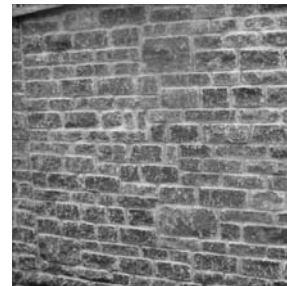
MAUER verblendet mit Naturstein (hammerrecht)
