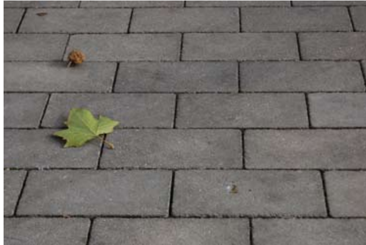
Betonsteinelement ohne Fase oder nur mit Mikrofase
