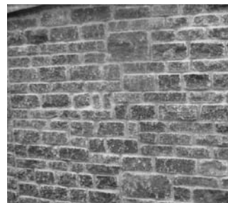
MAUER verblendet mit Naturstein (hammerrecht)
