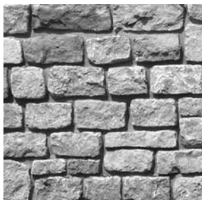
MAUER Naturstein, zurückgesetzte Fuge
