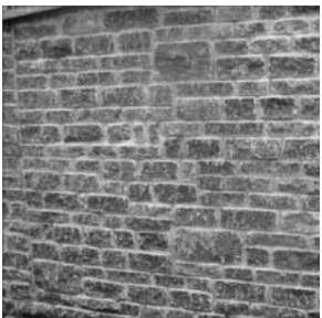
MAUER verblendet mit Naturstein (hammerrecht)
