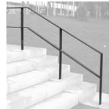
HANDLAUF Knieleiste, Flachstahl
