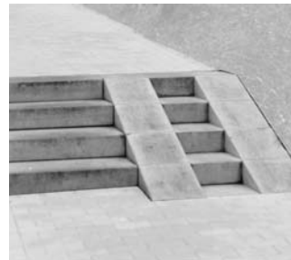
TREPPE Blockstufen, Rampe, Beton
