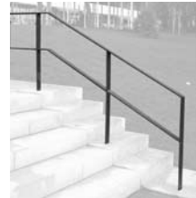
HANDLAUF Knieleiste, Flachstahl
