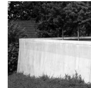
MAUER Ortbeton, konstruktive Fase
