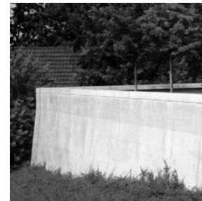
MAUER Ortbeton, konstruktive Fase
