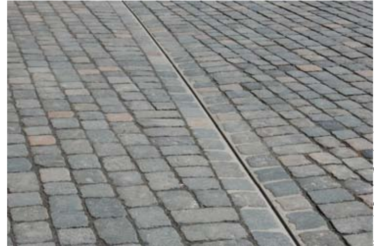
Schlitzrinne gebunden verlegt; anschließend Großpflaster in Reihenverband in ungebundener Bauweise
