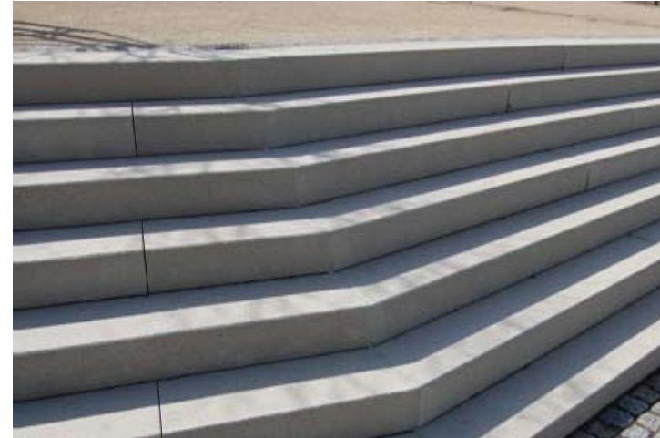
Fase an der Stufenvorderkante erleichtert die Benutzung der Treppe, Stoßfugen der Treppenstufen ohne Fase
