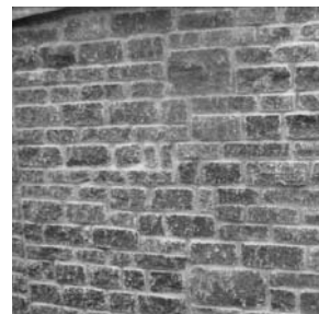
MAUER verblendet mit Naturstein (hammerrecht)
