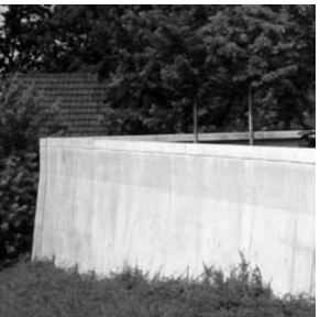
MAUER Ortbeton, konstruktive Fase
