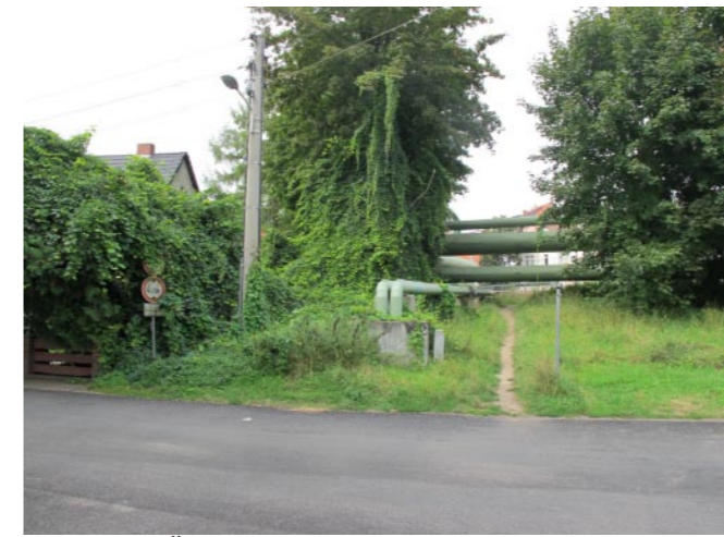
1 - fehlender Übergang zur Stadt / Barriere Fernwärmetrasse
