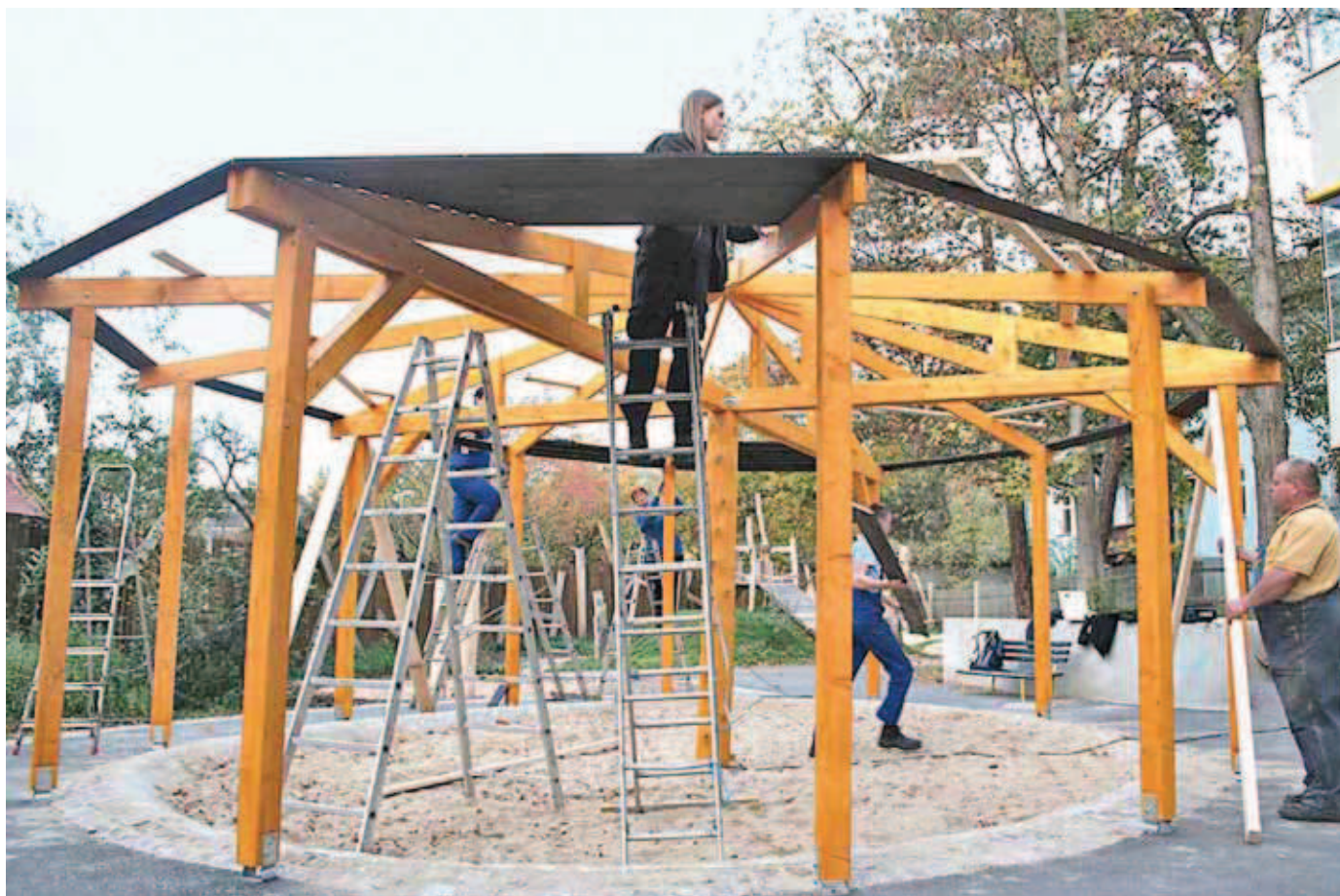
1 Aufbau einer Überdachung für einen Sandkasten durch die ÜAG gGmbH Jena
