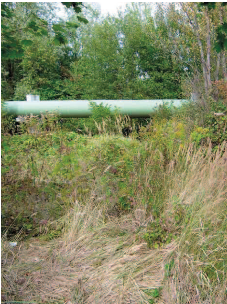
2 Durch Fernwärmetrasse und Verwilderung versperrter Flusszugang vom Gewerbegebiet Jena-Süd aus
