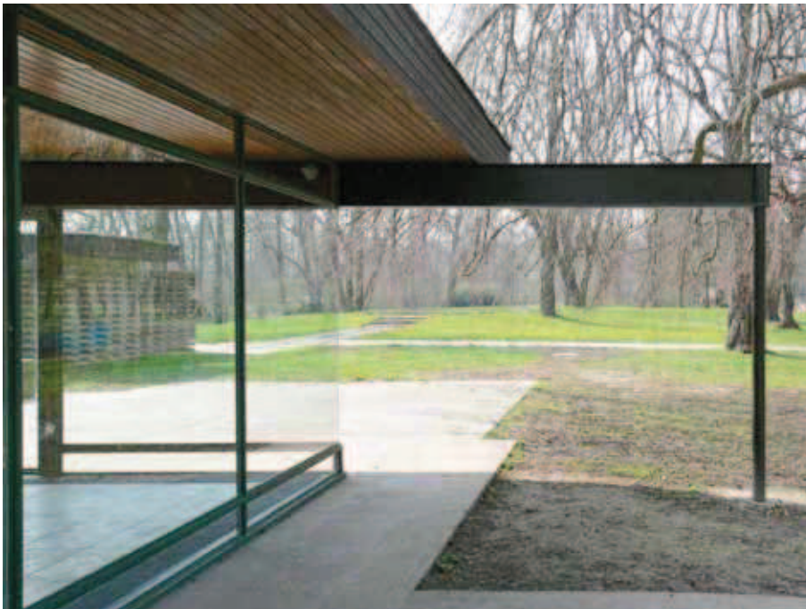
4 Jena, Oberaue, Pavillon, Blick aus dem Hauptraum. Aufhebung räumlicher Grenzen durch die Ausbildung der rahmenlos ausgeführten gläsernen Ecke und das weit in den vorgelagerten Außenraum greifende „spider leg“
