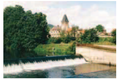
3 Paradieswehr noch ohne Fischtreppe
