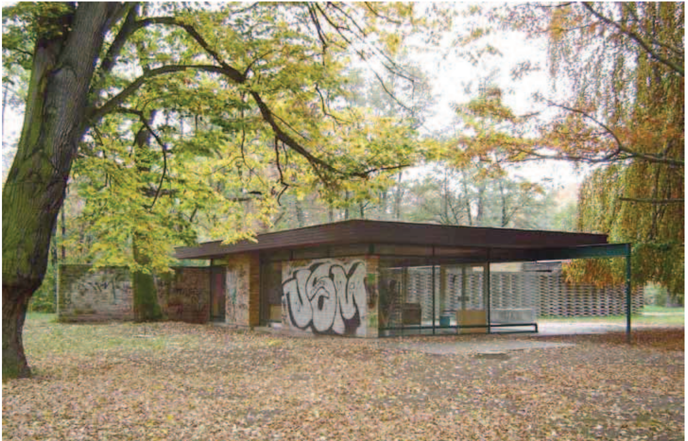
1 Jena, Oberaue, Pavillon, Ansicht des Hauptbaukörpers von Norden
