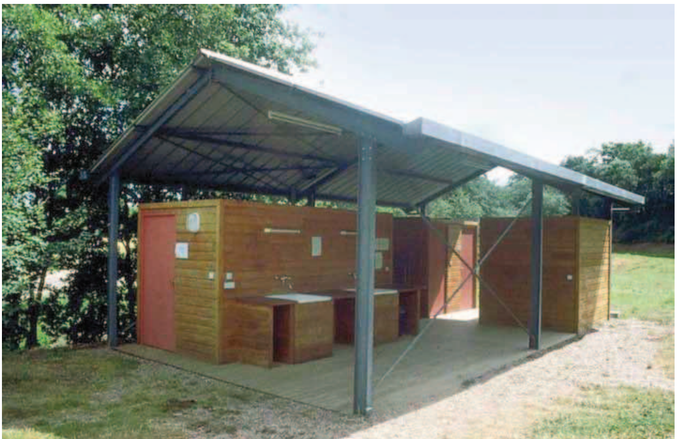
3 Servicestation für Wanderer, Wasserwanderer und Radtouristen am Canal du Nivernais, Frankreich
