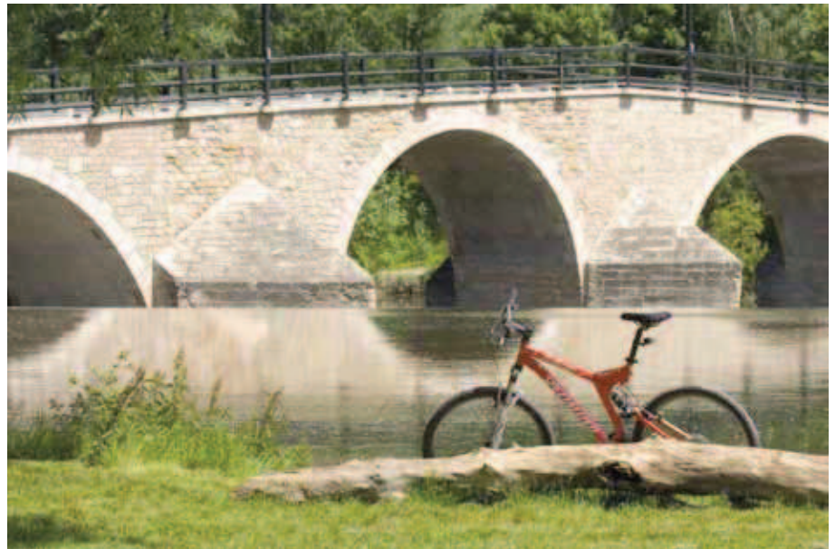
2 Rast an der wiederaufgebauten Burgauer Brücke
