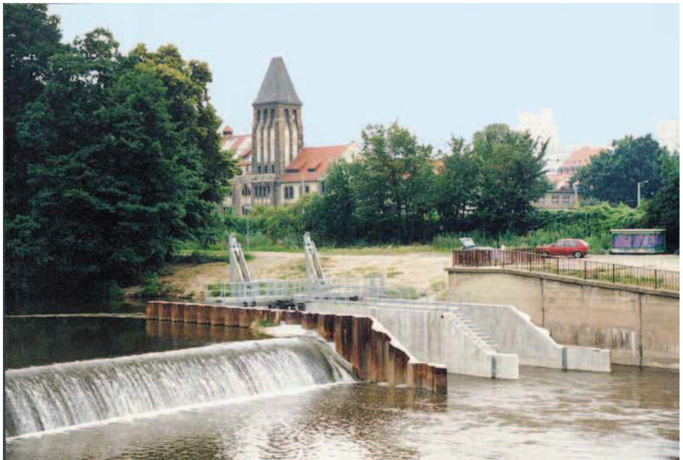
1 Paradieswehr mit Wasserkraftanlage, im Hintergrund der Turm des Volksbades
