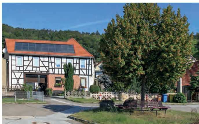
Abbildung 46: Im historischen Ortskern ist noch eine Vielzahl von Hofanlagen vorhanden. In einem Fall werden die Gebäude noch hauptberuflich landwirtschaftlich genutzt.
