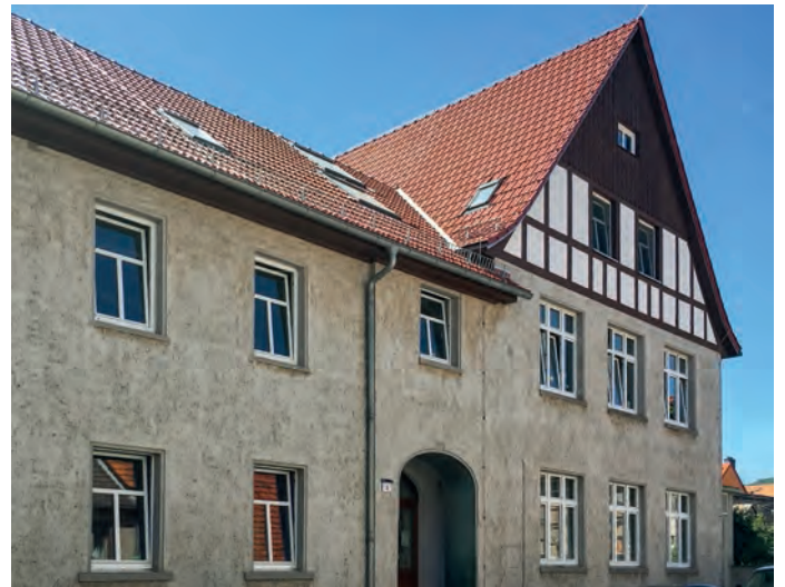
Abbildung 117: Die ehemalige Dorfschule zählt zu den ortsbildprägenden Gebäuden im Ortskern und wird heute für soziale Vereinsarbeit und durch eine Kindertagesstätte genutzt.
