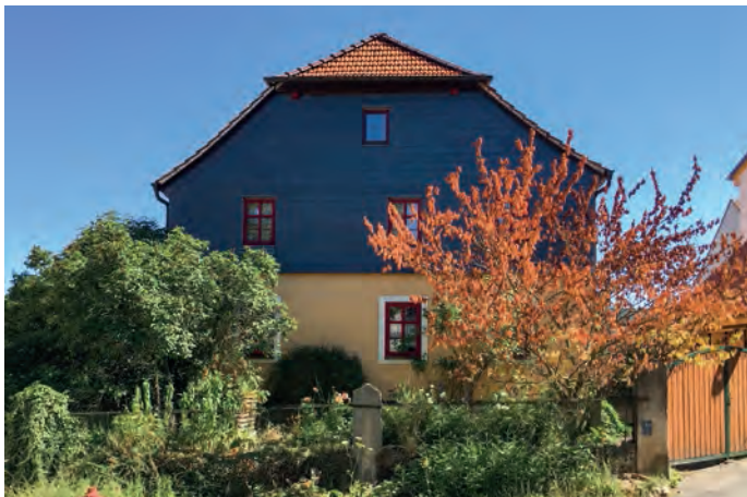
Abbildung 104: Das alte Pfarrhaus ist behutsam saniert worden und prägt das Ortsbild am Anger.
