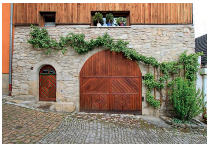
Abbildung 140: Ein sensibel saniertes Wohngebäude mit Fassadenbegrünung bereichert das Ortsbild von Zwätzen.
