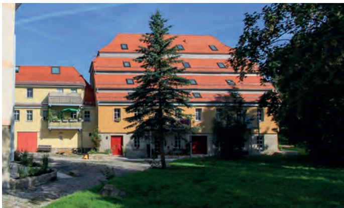
Abbildung 95: Die alte Mühle dokumentiert die Nutzung der Wasserkraft zu verschiedenen Zeitepochen – das Denkmal der geschichtlich-technischen Dorfbildpflege wurde zum Wohnen ausgebaut.
