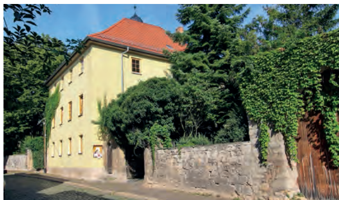
Abbildung 92: Zum ortsbildprägenden Gebäudebestand gehört das Pfarrhaus mit seinem Natursteinportal.
