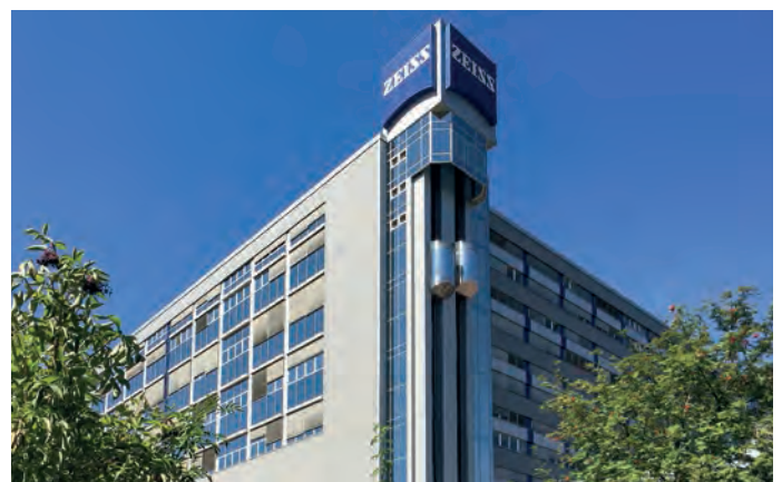
Abbildung 101: Das Zeiss-Werk überragt den Ortsteil Lichtenhain und beeinträchtigt das Ortsbild erheblich.
