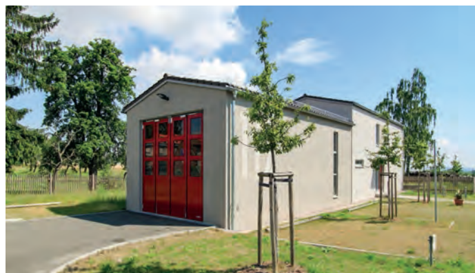
Abbildung 79: Zur Gewährleistung des Brand- und Katastrophenschutzes ist im Jahre 2014 der Neubau eines Feuerwehrgerätehauses erfolgt.
