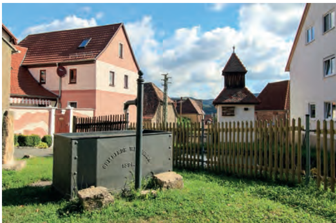
Abbildung 130: Das Trafohaus im Hintergrund versorgte den Ortsteil bis Ende der 1960er Jahre mit Strom. Als Tierhotel für Vogel- und Fledermausarten dient das Gebäude heute dem Artenschutz.
