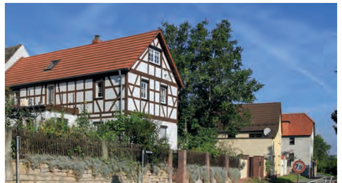
Abbildung 43: Die historischen Gehöftanlagen weisen überwiegend einen guten Bauzustand auf, dienen aber zumeist nur noch dem Wohnen.
