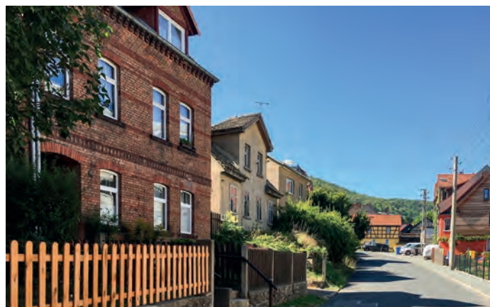
Abbildung 100: Die Mühlenstraße weist durch das geschlossene Straßenraumensemble von Gebäuden und Toranlagen eine hohe städtebauliche Qualität auf.
