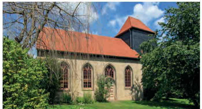
Abbildung 52: Das einschiffige Langhaus des Kirchengebäudes stammt im Wesentlichen aus der Zeit um 1856, wurde aber auf den Mauern einer Vorgängerkirche aus den Jahren um 1250 errichtet.
