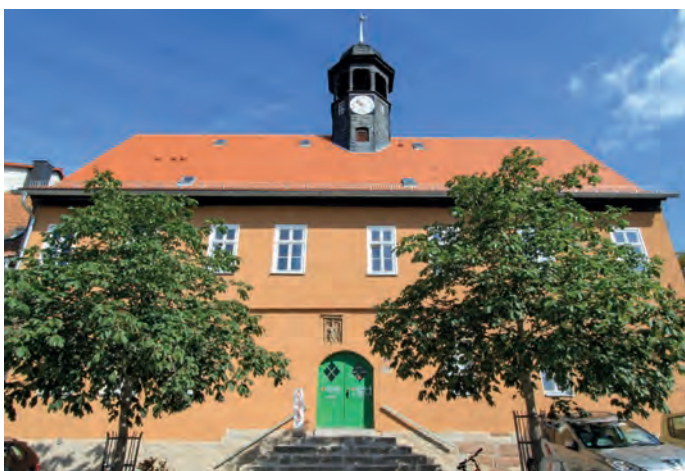
Abbildung 113: Das denkmalgeschützte Rathaus kündigt von der Verleihung des Stadtrechtes an die mittelalterliche Siedlung Lobeda.
