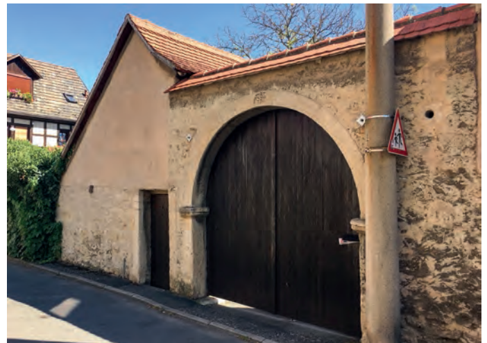
Abbildung 120: Ein denkmalgeschütztes Torportal aus Muschelkalk als interessantes Detail und prägend für den Löbstedter Ortskern.
