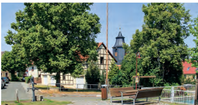
Abbildung 75: Die unter Ensembleschutz stehende alte Ortslage ist gekennzeichnet durch die ringförmige Anordnung der Gehöfte um einen zentralen Platz, der mit einem Dorfteich ausgestattet ist.
