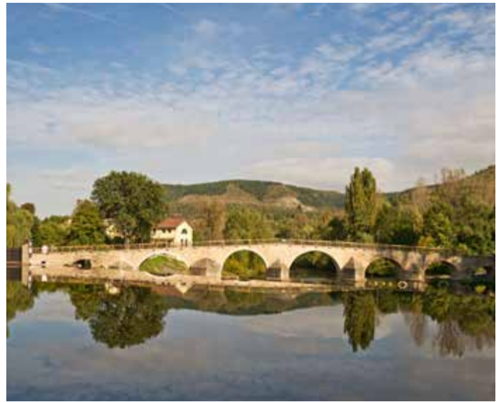
Wiedererrichtete Steinbogenbrücke Jena-Burgau
