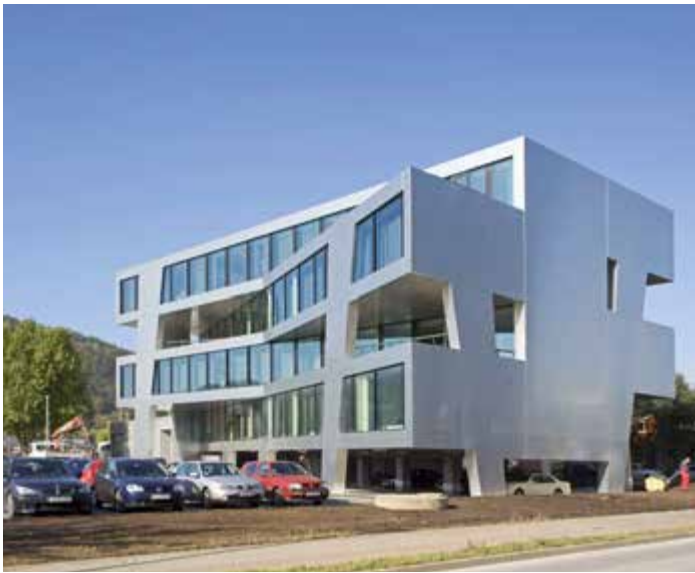
GÖPEL electronic im Gewerbegebiet Göschwitz, Architektur: wurm + wurm – architekten und ingenieure GmbH
