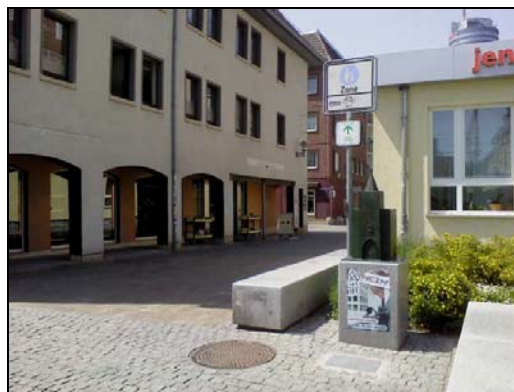
Eingangsbereich ungenügend gestaltet
