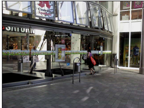
Fehlen automatischer Türen im Eingangsbereich der Goethe Galerie
