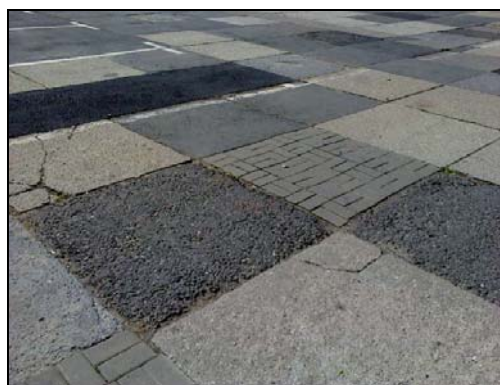
Provisorische Befestigung ausgedehnter Teile des Eichplatzareals
