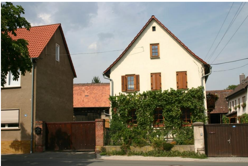
Gelungene Sanierung eines bäuerlichen Wohnhauses
