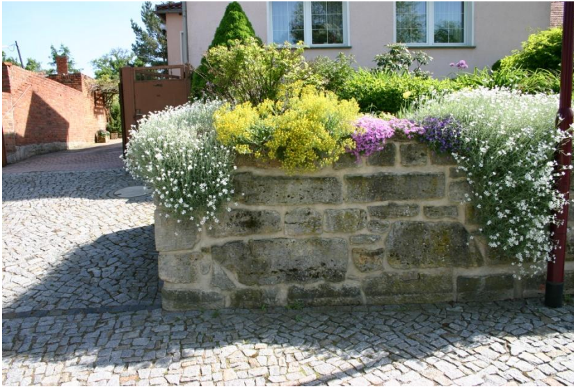
Stützmauern aus Muschelkalk mit Polsterstauden bereichern das Ortsbild.
