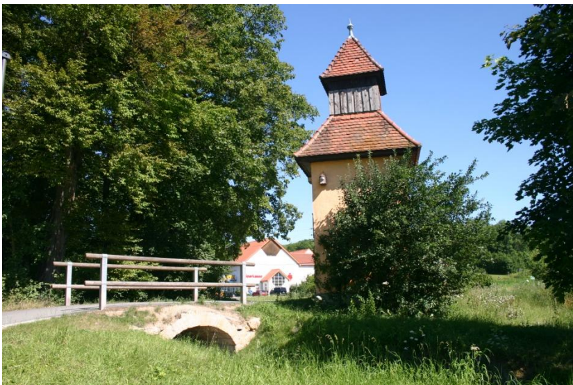
Historisches Trafohaus mit neuer Nutzung als Artenschutzgebäude für Mauersegler und Fledermäuse
