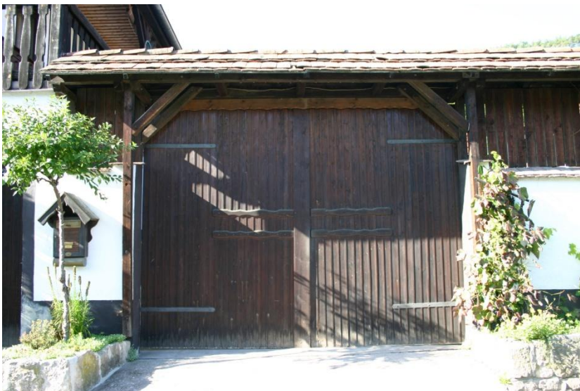
Gehöftverbindende überdachte zweiflügliche Toranlage
