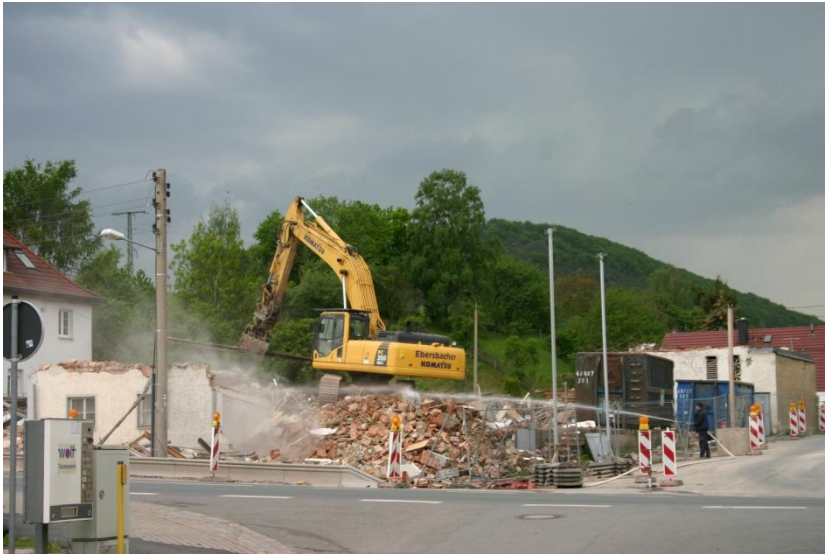
Fotodokumentation: Vorbereitung des Umbaus der Bundesstraße im Jahre 2012
