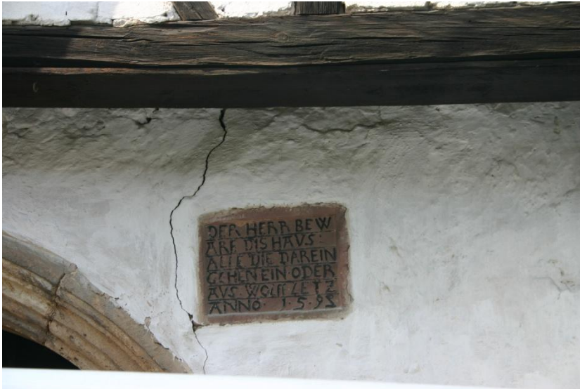
Torinschrift an der historischen Wassermühle von 1595
