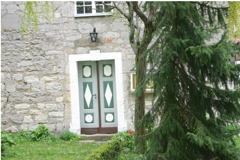
Handwerklich gefertigte Kassetentür an der Kirche
