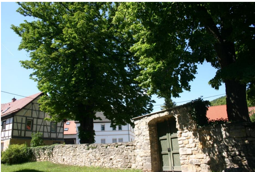
Kirchenmauer aus Muschelkalkbruchsteinen mit Eingangstür
