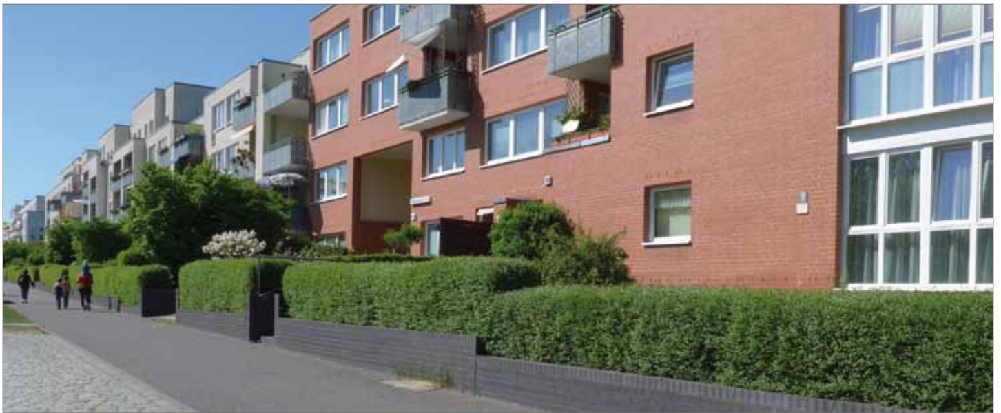
Einheitliche Gestaltung der Vorgarteneinfriedung; Eisenacher Straße, Berlin
