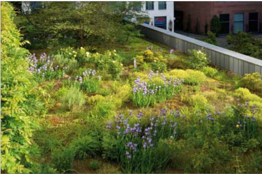
Intensive Dachbegrünung mit Stauden, Sträuchern und Fassadenbegrünung; Dessau
