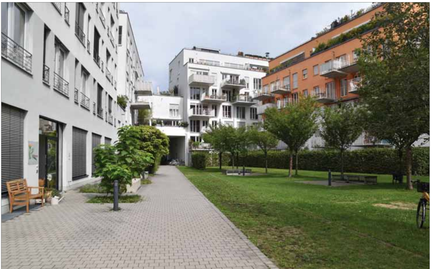
Grünhof über Tiefgarage zur Nutzung durch die Anwohner; Ackermannbogen, München
