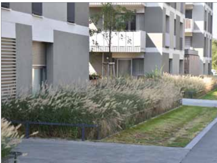
Niederschlagswasserableitung entlang der Vorgärten; Seestadt Aspern, Wien
