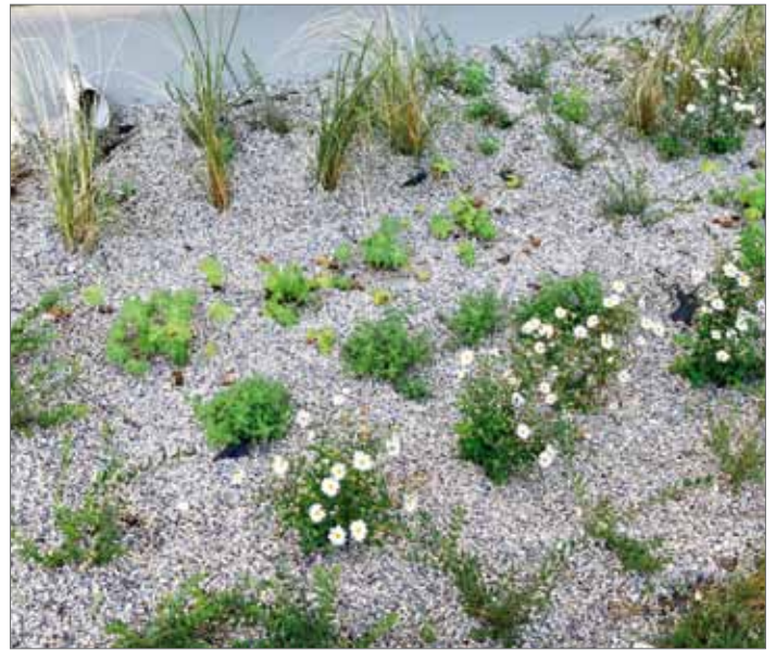
Regenwassernutzung für Gründach; Seestadt Aspern, Wien
