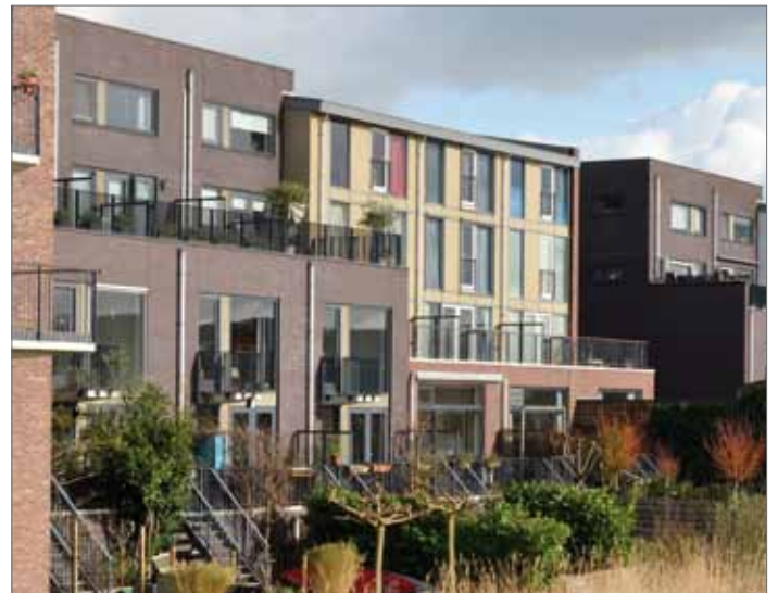
Gartenseite von mehrgeschossigen gereichten Wohnhäusern; IJburg, Amsterdam
